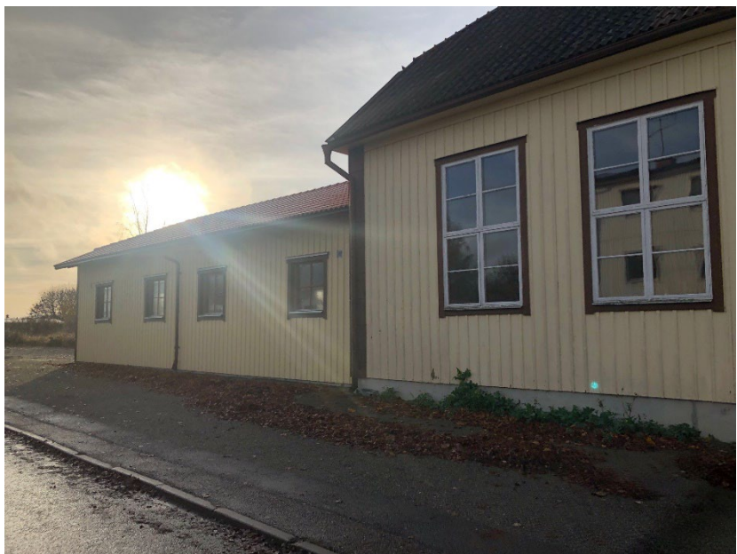
Huvudbyggnad till höger och tillbyggnad till vänster (Enköpings kommun).
